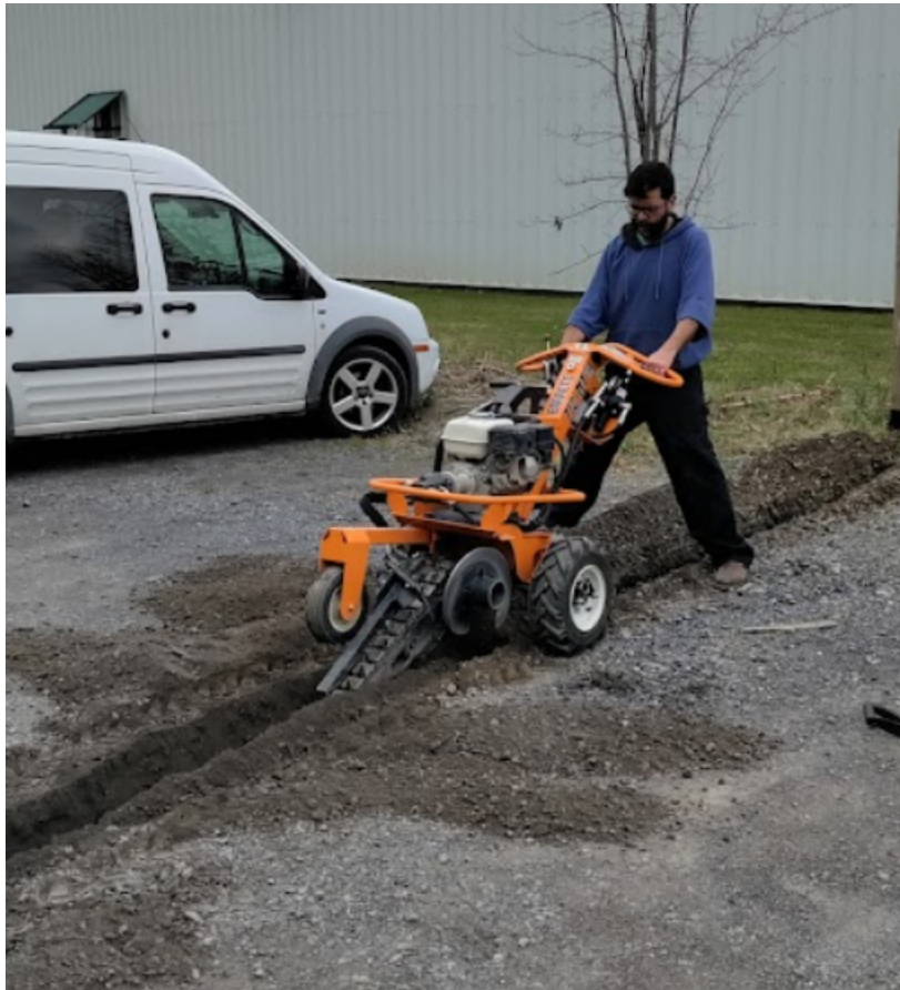
Figure 5 - Excavation de la tranchée sur le site d'essai
