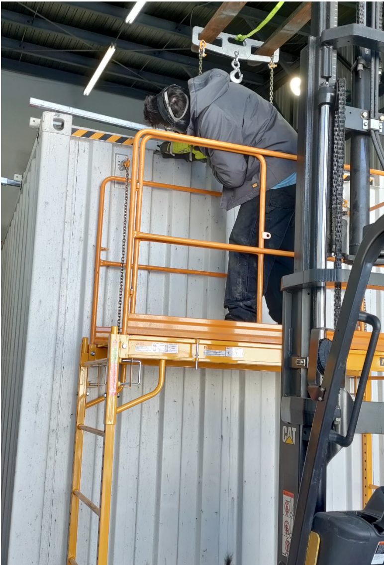
Figure 4 – Travaux de soudure et montage du système dans la station
