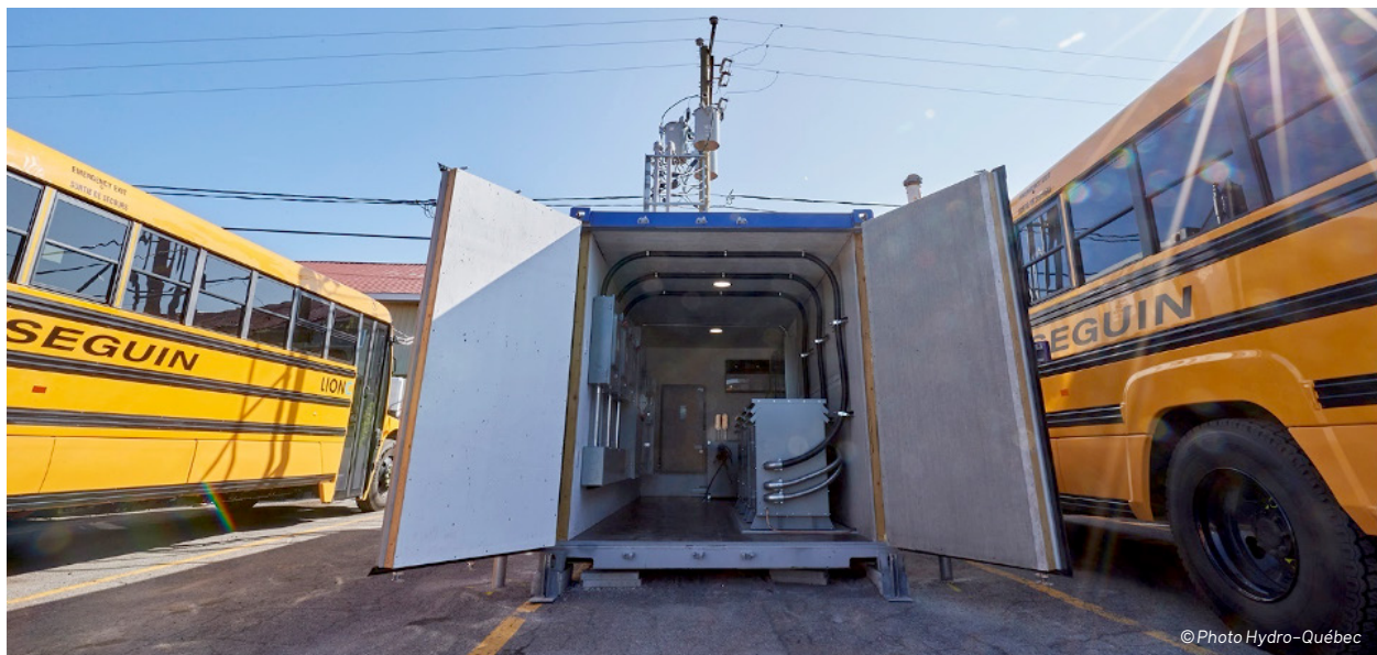
FIGURE 5 • Installation par Cléo d'un conteneur pour Autobus Groupe Séguin pouvant alimenter jusqu'à 12 bornes de recharge, 260 kW
