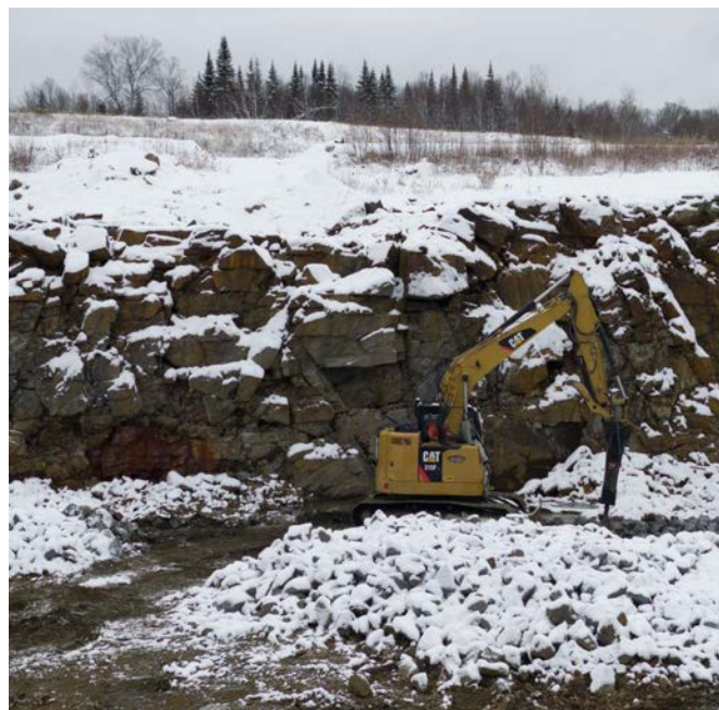
Figure 5 - Travaux de concassage sur le gisement de Nouveau Monde Graphite
