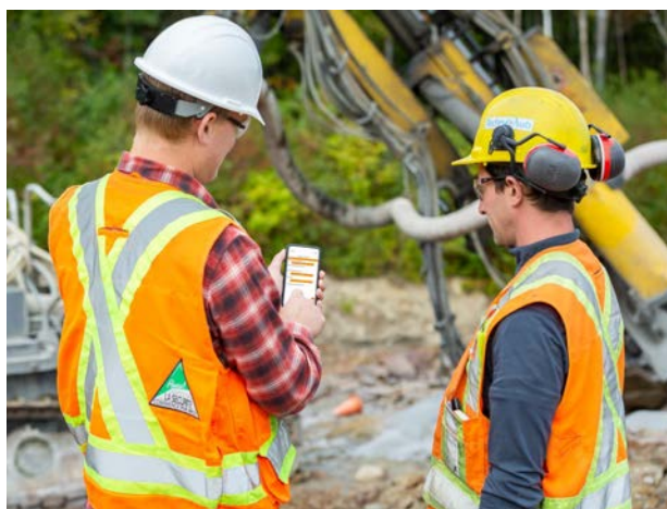
Figure 10 - Utilisation de l'application mobile Geotrace
